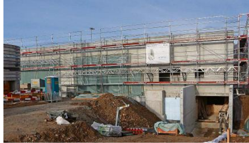
Auf dem Dach des im Bau befindlichen Feuerwehrmagazins wird eine Fotovoltaikanlage installiert. (AE)
