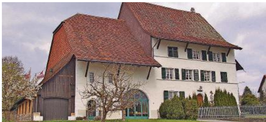
Die Tür zum Pfarrhaus muss isoliert und verstärkt werden.
