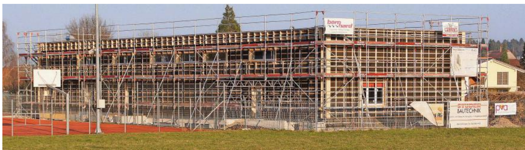
Die Bauarbeiten für das neue Feuerwehrmagazin in Neuendorf kommen zügig voran.
