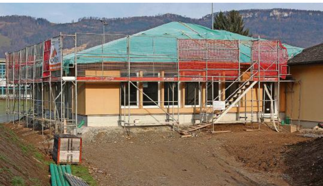
Der Kindergarten (links) wird mit Planen vor Nässe geschützt, das Feuerwehrmagazin verfügt bereits über eine wasserdichte Deckenplatte.
